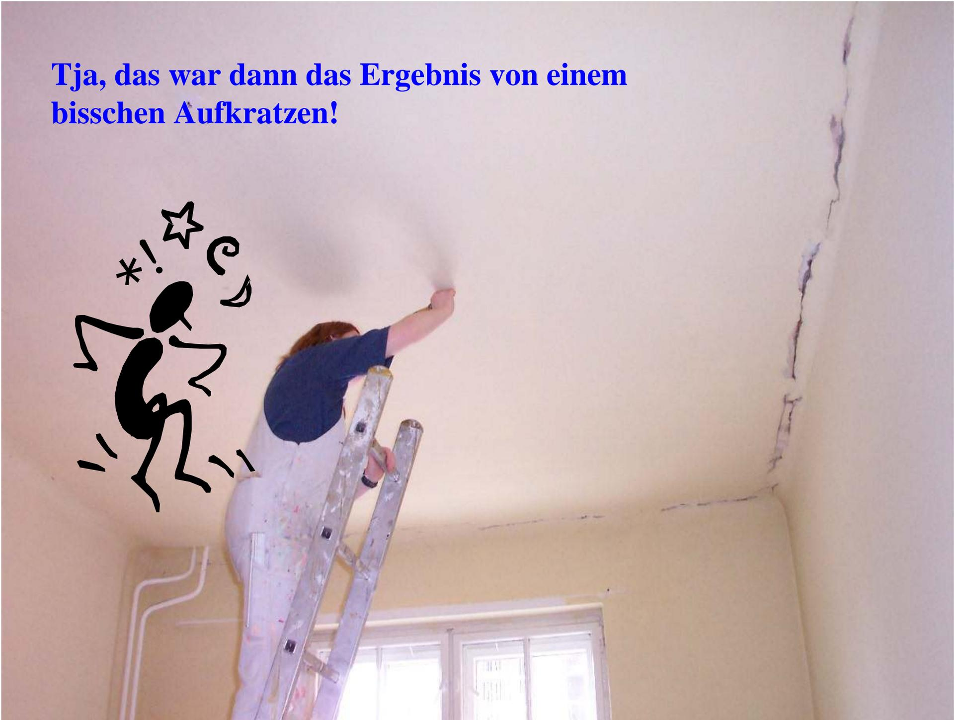
*Wir haben angefangen, die sehr großen Risse mit mineralischer Spachtelmasse, die kleineren mit Acryl auszufüllen. Dann wurde mit plastoelastischer Spachtelmasse darüber gespachtelt. In diese Spachtelmasse haben wir Glasgewebe eingebettet, um die Risse zu überbrücken, und zum Schluss wurde das Gewebe mit einer plastoelastischen Schicht überdeckt.*
