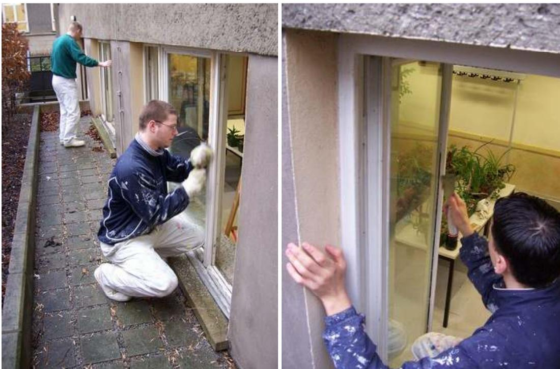
Nach dem Abschaben haben wir das komplette Fenster mit 120er Schleifpapier und einem Schleifklotz geschliffen und abgestaubt.
